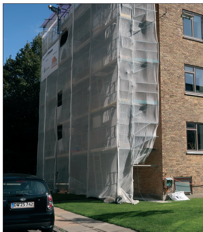
Renoveringen af gavlen i nr. 52 er i gang.
