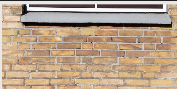
Porøse/nedbrudte fuger
